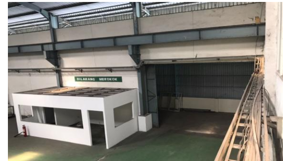
PEKERJAAN PARTISI SEKAT AREA DALAM PABRIK
