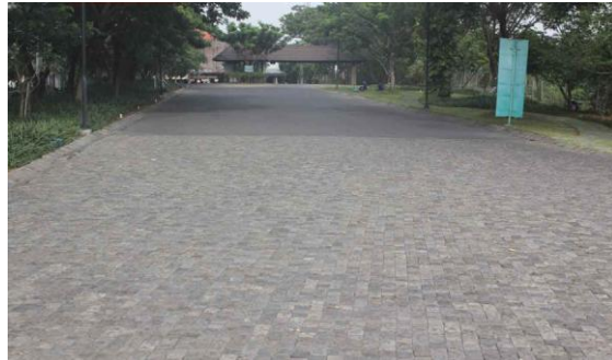
INFRASTRUKTUR JALAN - PAVING
