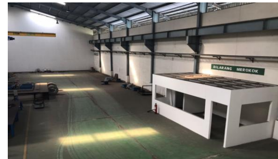
PEKERJAAN PARTISI SEKAT AREA DALAM PABRIK
