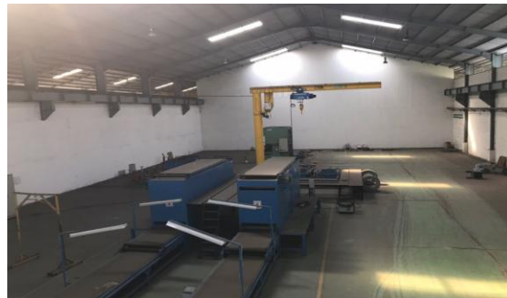
PEKERJAAN PARTISI SEKAT AREA DALAM PABRIK
