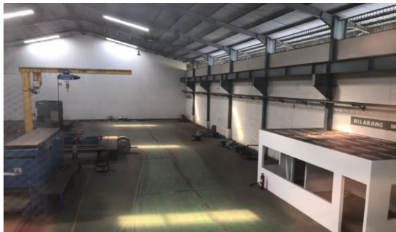
PEKERJAAN PARTISI SEKAT AREA DALAM PABRIK
