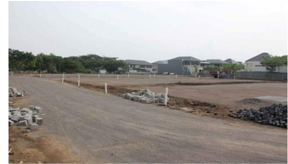
INFRASTRUKTUR JALAN - PAVING
